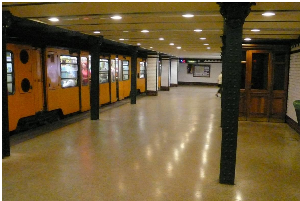
37. ábra Megálló belső képe - tipikus födémek, padló és falburkolatok, atipikus pillérköpenyezés (Bajcsy Zs. út)
