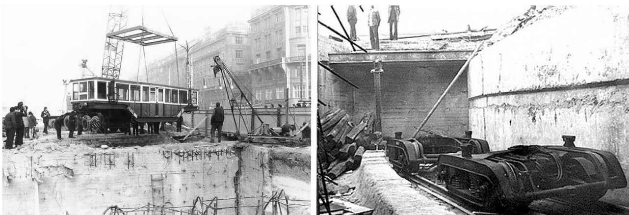
117. ábra: a Földalatti Vasúti Múzeum szerelvényeinek beemelése 1972-ben a felhagyott alagútszakaszba
